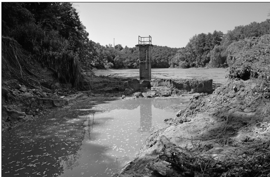
7. számú ábra: Galambok településen található tározó átszakadt töltése. Forrás: A szerzők saját szerkesztése
