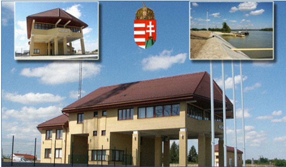
2. számú ábra: A Mohács Vízi Határátkelőhely épülete
