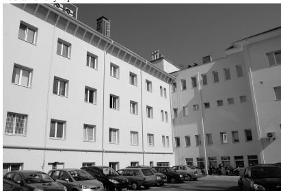
Homlokzat utólagos szigetelése
