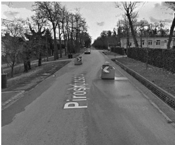
9. kép: XVI. kerület, Sashalom - Forgalmocsillapítás térelemekkel (Forrás: Google maps)
